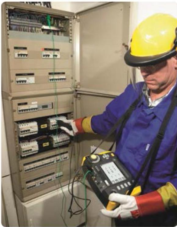
在民用、第三产业和工业环境领域，这些新型多功能安装测试仪可用于检测电气设备是否符合适用标准的规定。
